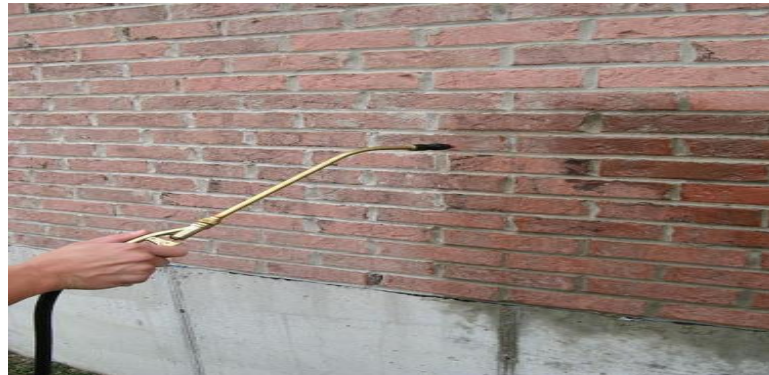
Hình ảnh: Phun chống thấm cho tường gạch không trát
