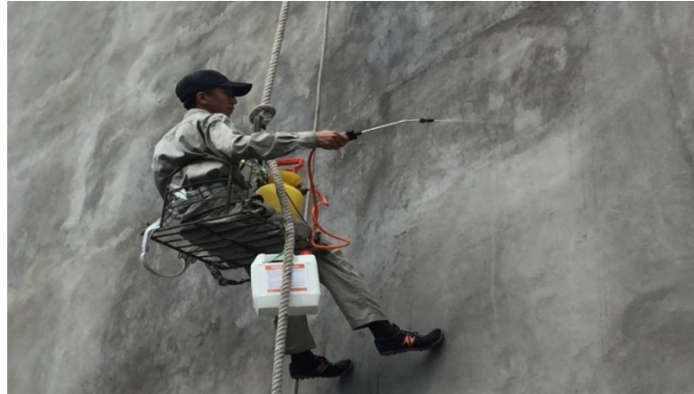
Phun chống thấm cho hông tường đứng
