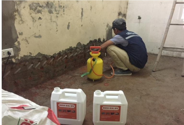
Hình ảnh: Bơm chống thấm chân tường bằng Water Seal DPC
